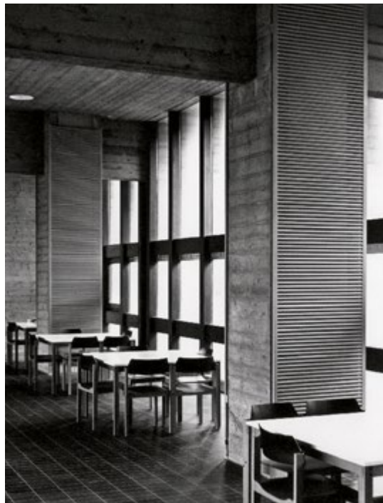
Einsäuliger Radiator als Pfeilerverkleidung um 1970. Der Einsäuler verband die moderne, zeitlose Form in vorteilhafter Weise mit geringer Bautiefe.
