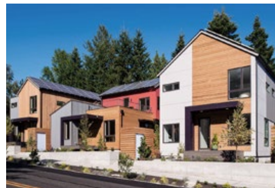
Die 130 Häuser der visionären «Grow Community» in der Nähe von Seattle, USA, sind komplett mit Lüftungsanlagen von Zehnder ausgestattet.
