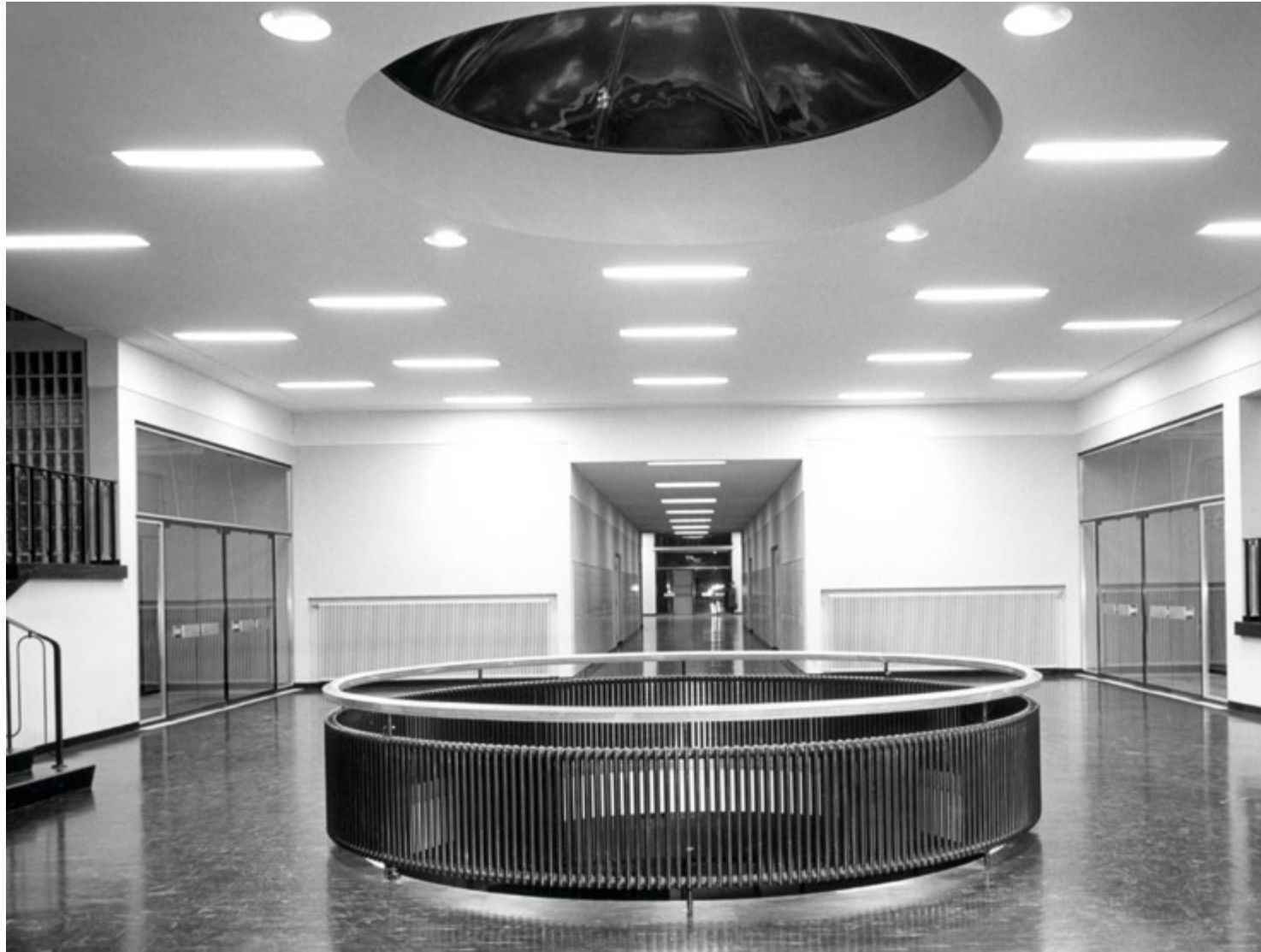
Auf Wunsch war der Zehnder-Radiator auch gebogen oder abgewinkelt erhältlich. Das Bild von der Schule Lavey-les-Bains bei St-Maurice zeigt den Radiator in einer architektonischen Funktion als Geländer.
